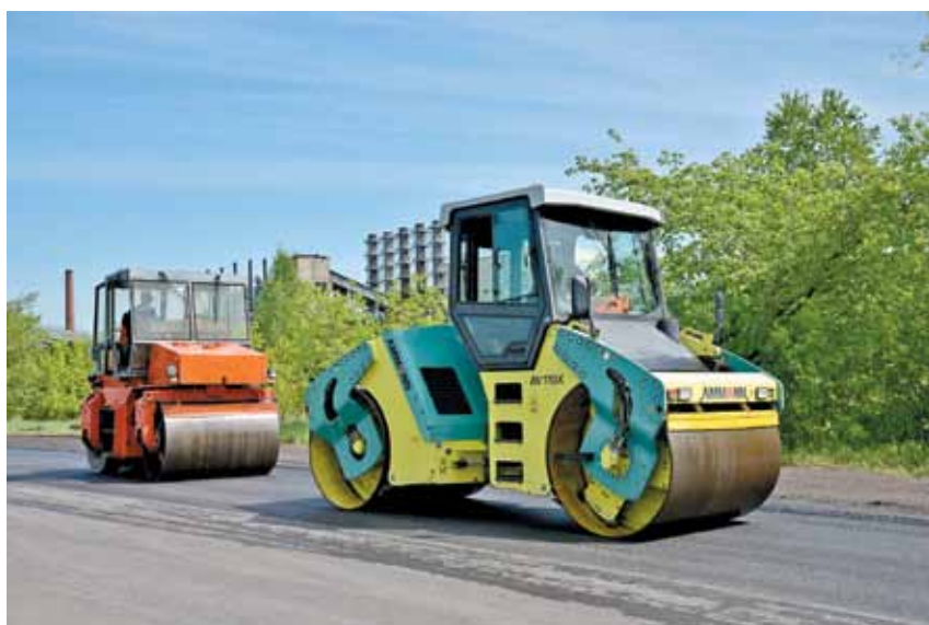
Капитальный ремонт на участке дороги Белово – Новый Городок
