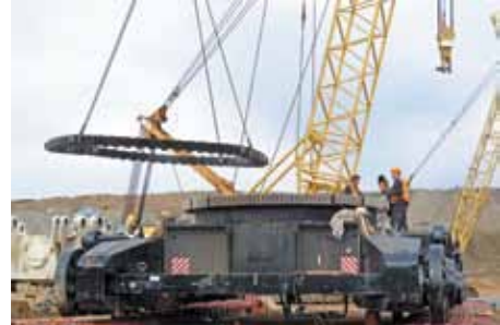
Монтаж экскаваторов отечественного и импортного производства
