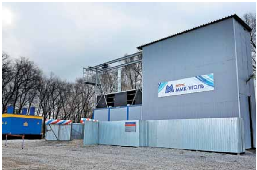
Котельная-робот в микрорайоне 8 Марта
